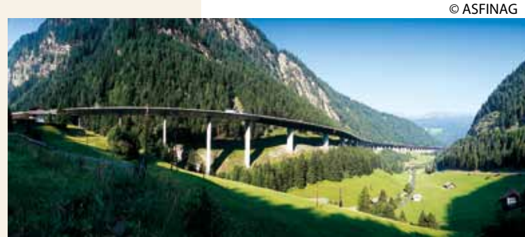
Le Luegbrücke, région du Tyrol, construit entre 1965 et 1968 The Luegbrücke, in the Tyrol Region, built between 1965 and 1968
