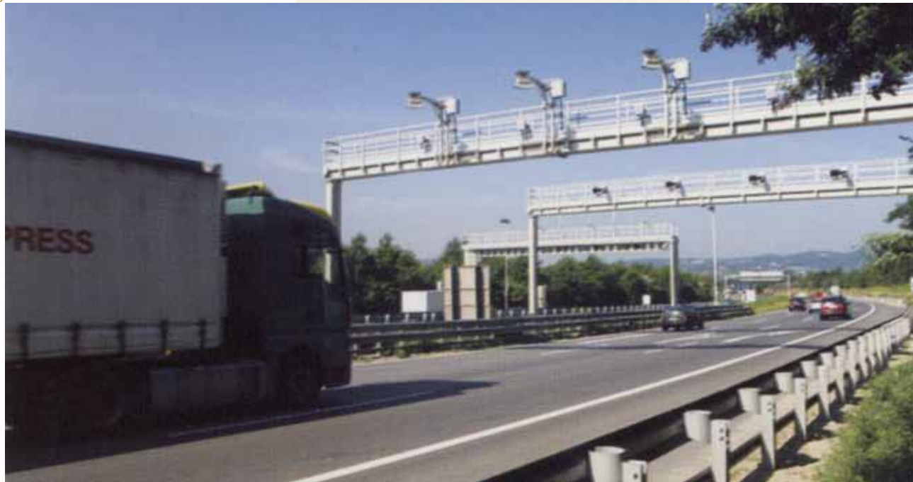
Portique pour péage kilométrique poids lourds Distance-based toll portal for trucks
