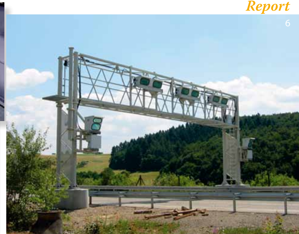
Photo 6 : portique de contrôle Picture 6: Toll control bridge
