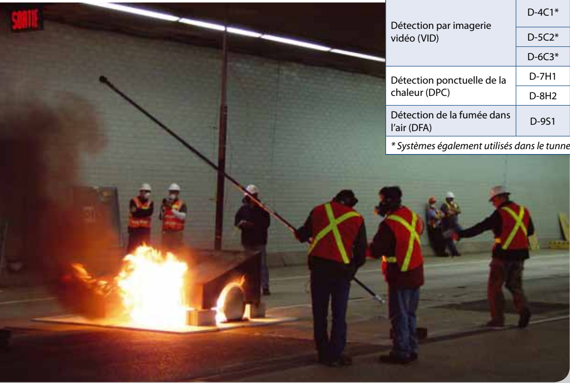
< Figure 2 - Photographie d'un essai d'incendie dans le tunnel Viger
