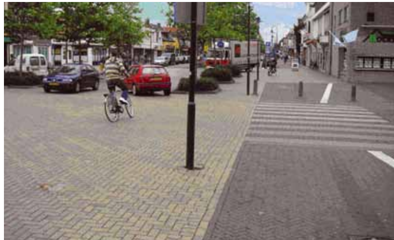
Figure 3 - Accès au carrefour Noordkade/Zuidkade avec des allées d'arbres pour canaliser la circulation, à Drachten (Pays-Bas) Figure 3 - Noordkade/Zuidkade intersection approach with bollards for channelisation, Drachten, the Netherlands
