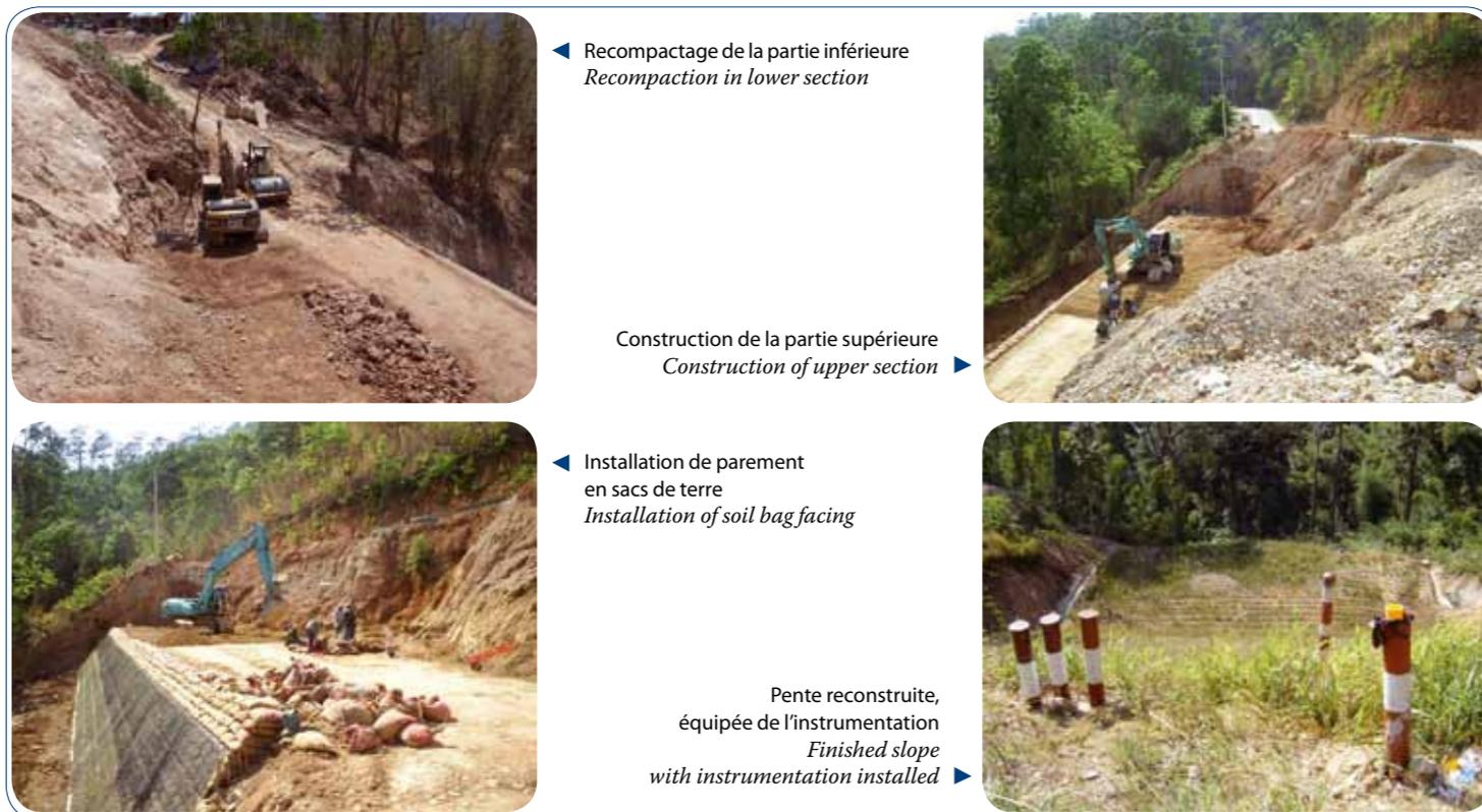
Figure 2 - Reconstruction de la pente, équipée de l'instrumentation
