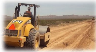
Rajah 4.3 : Gambaran kerja-kerja bagi lapisan subgred
